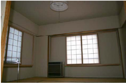
施工後の写真
